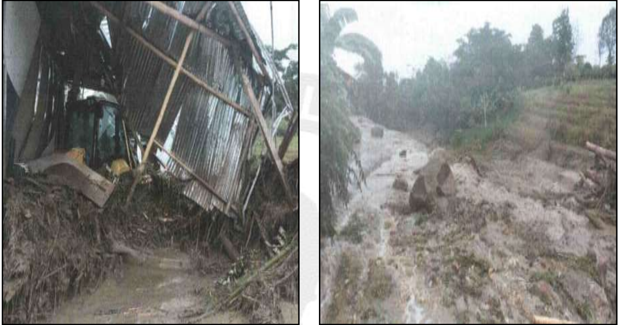
Cultivos afectados por la activación de la quebrada en el distrito de La Peca.
