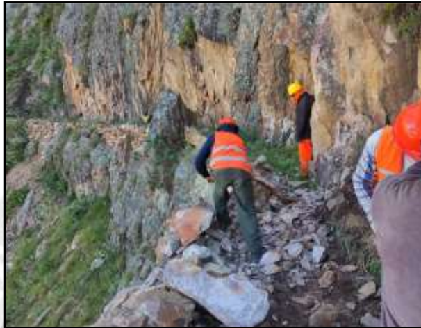
Trabajos de limpieza y rehabilitación del canal de riego
