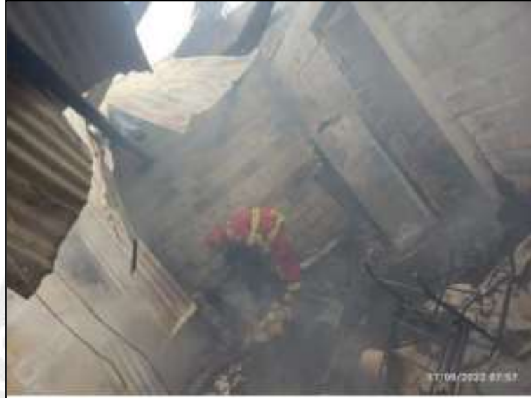
Vivienda inhabitable producto del incendio urbano
