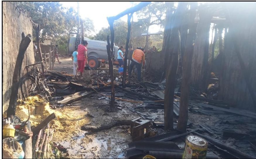
Vivienda inhabitable por el incendio urbano en el distrito de Jayanca
