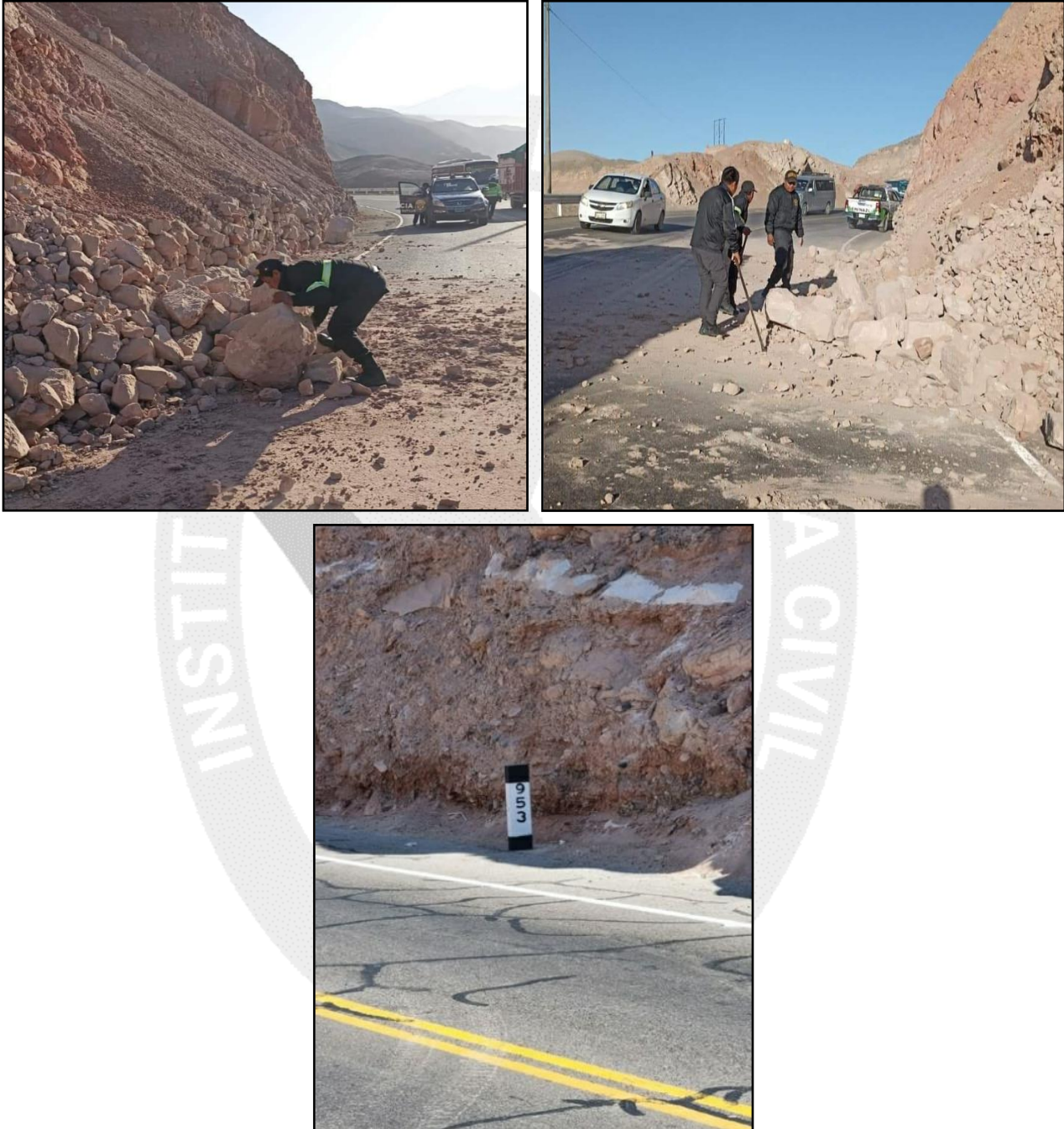
Trabajos de limpieza de caídas de rocas en el distrito de Vitor
