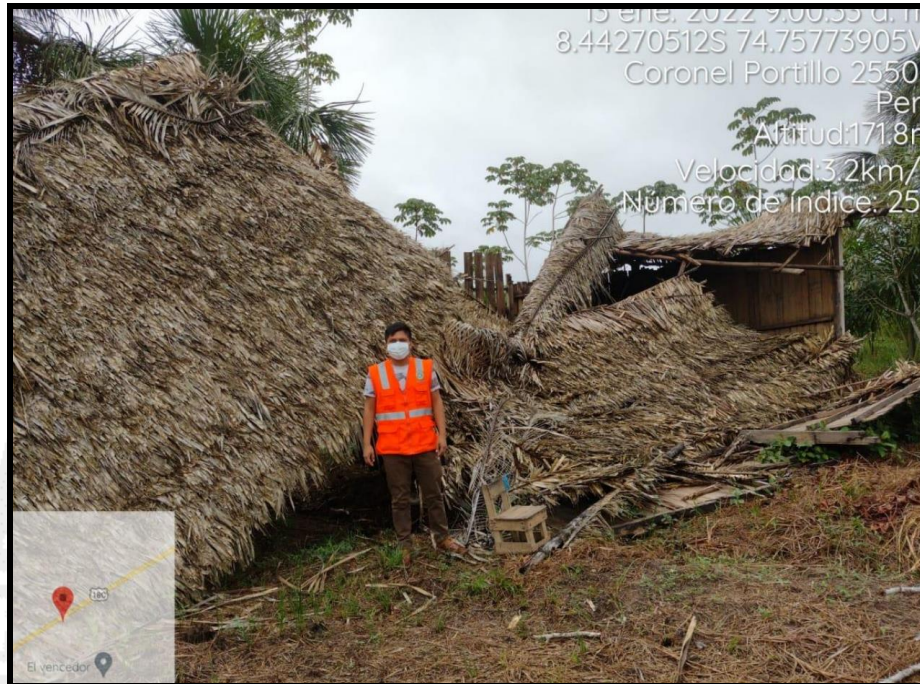
Vivienda afectada en el distrito de Campo Verde
