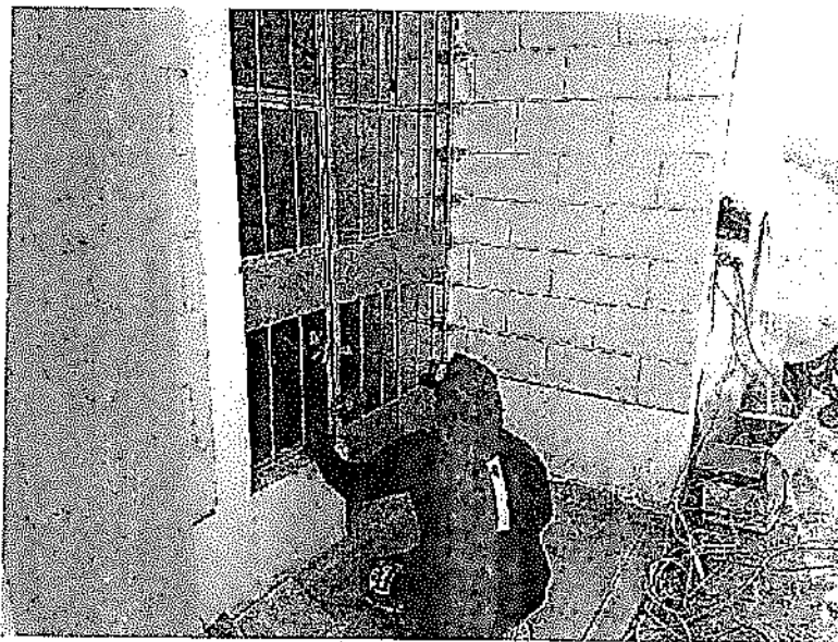
FOTO 37 INSTALACION DE PUERTA METALICA 10/10/2019
