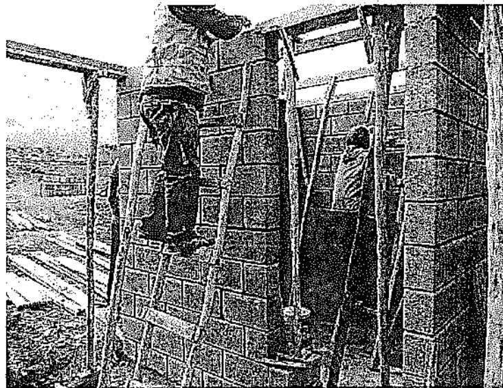
FOTO 24 ENCOFRADO LOSA ALIGERADA – AGUÁ SALADA 18/08/2019
