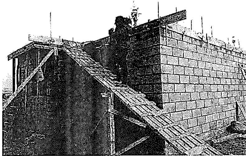
FOTO 31 VACIADO DE LOSA Y VIGAS – AGUA SALADA 10/09/2019
