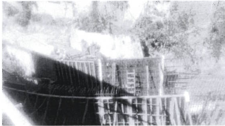
IMAGEN N° 03: Afianzamiento de la Parte Estructural de la Sección Rectangular, para llevar un adecuado Control del metrado diario en campo de todo el proceso constructivo de la obra del 0+400 al 1+200.
