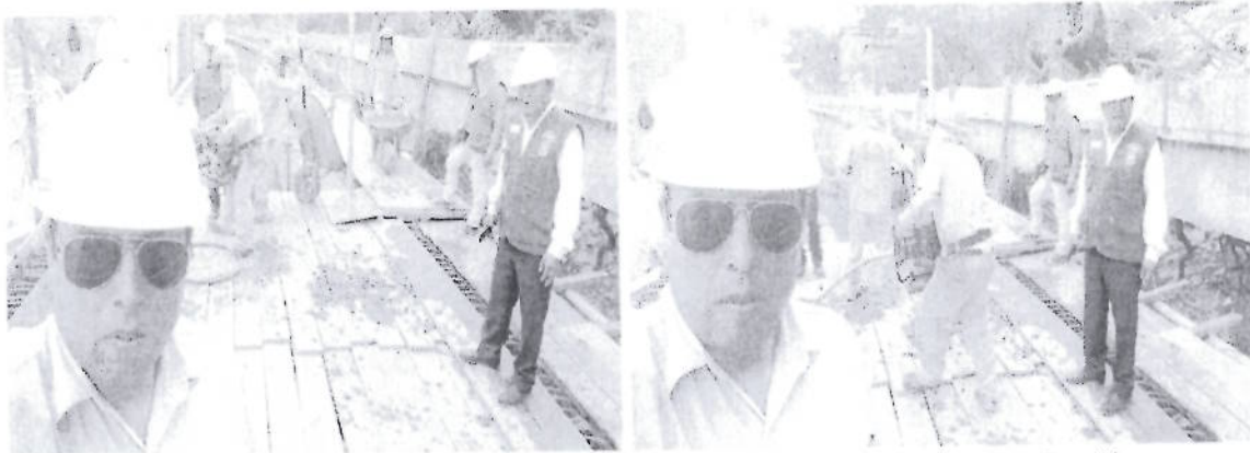
IMAGEN N° 08: Verificación de llenado de concreto en las diferentes progresivas en coordinación con los diferentes responsables de obra.
