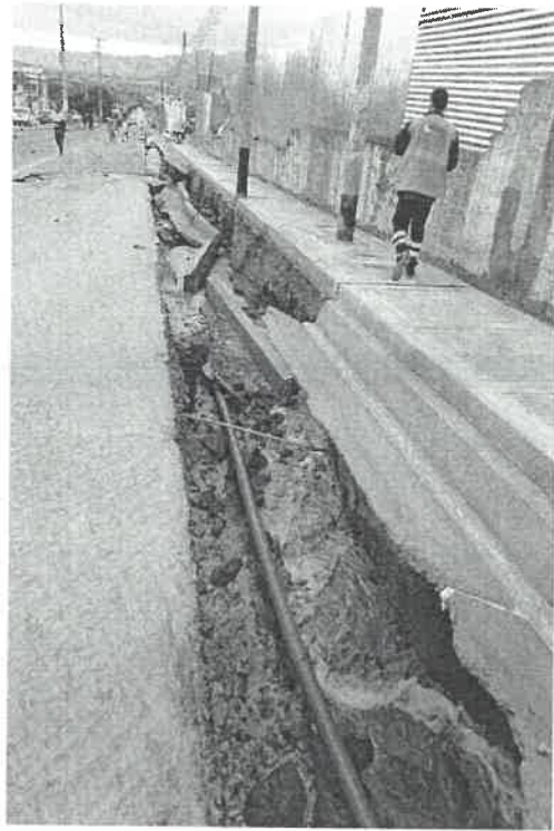
ROTURA DE TUBERIAS DE DESAGUE
