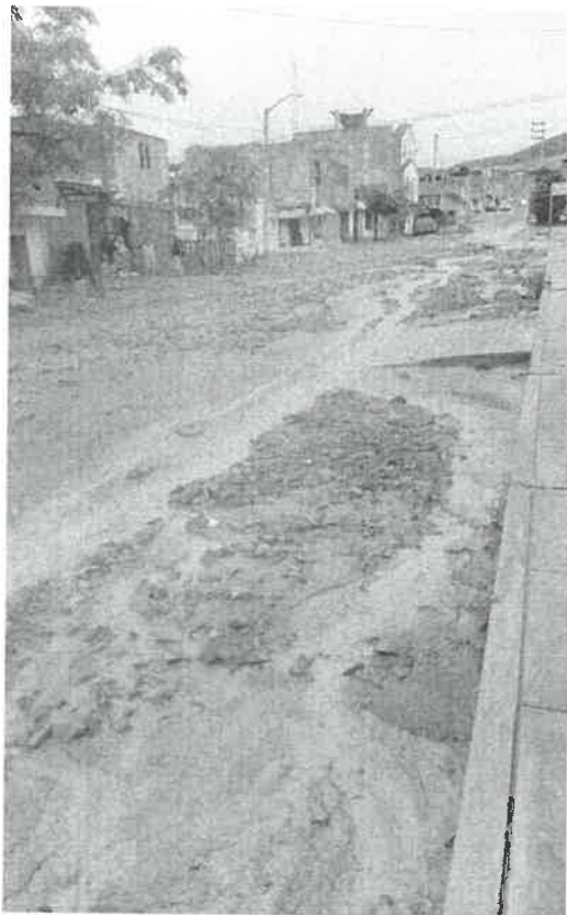
ROTURA DE TUBERIAS DE DESAGUE
