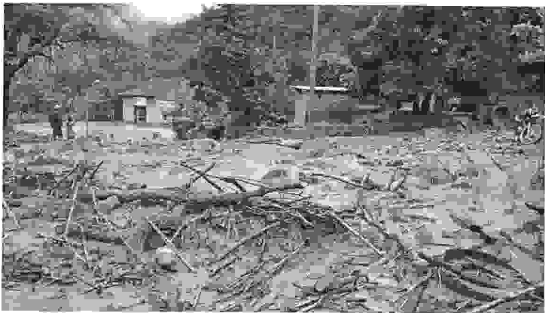
IMAGEN N°02. Afectación total del acceso a la central hidroeléctrica de La Atuyunga.
