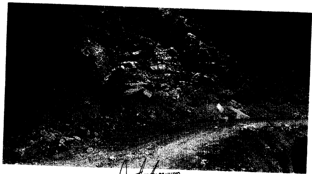
FOTO N° 02: Deslizamiento de talud superior en carretera Cochas - Amangay, evento de intensas lluvias, ocurrido el día 10 de marzo del 2020. Daños perjudicaron el paso de los vehículos, ubicados entre las progresivas KM 0 + 120 y KM 0 + 475
