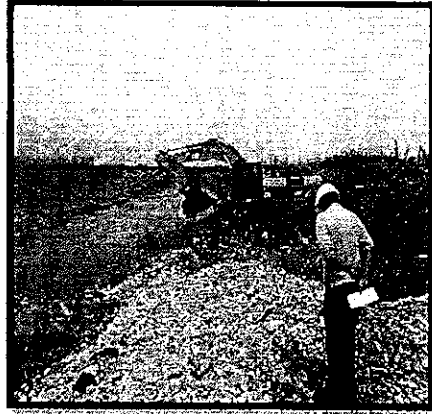
Replanteo en dreña a tajo abierto y descolmatación
