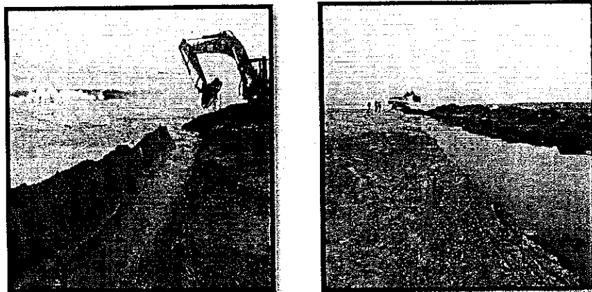
Desembocadura de las aguas provenientes del Lado A al mar
