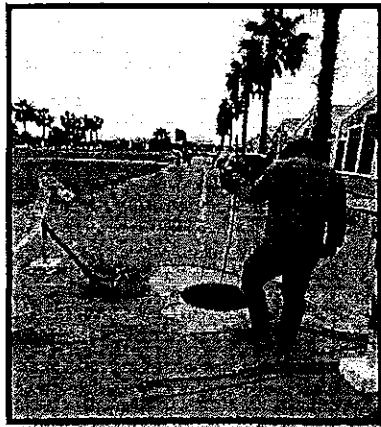
Empleo de varillas flexibles para permitir la remoción de elementos que obstruyen el paso del agua y relleno en zona donde se instaló tubería para unir dren tajo abierto con sistema de drenaje de ESTAMI.
