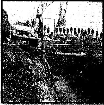
Replanteo en dreña a tajo abierto y descolmatación
