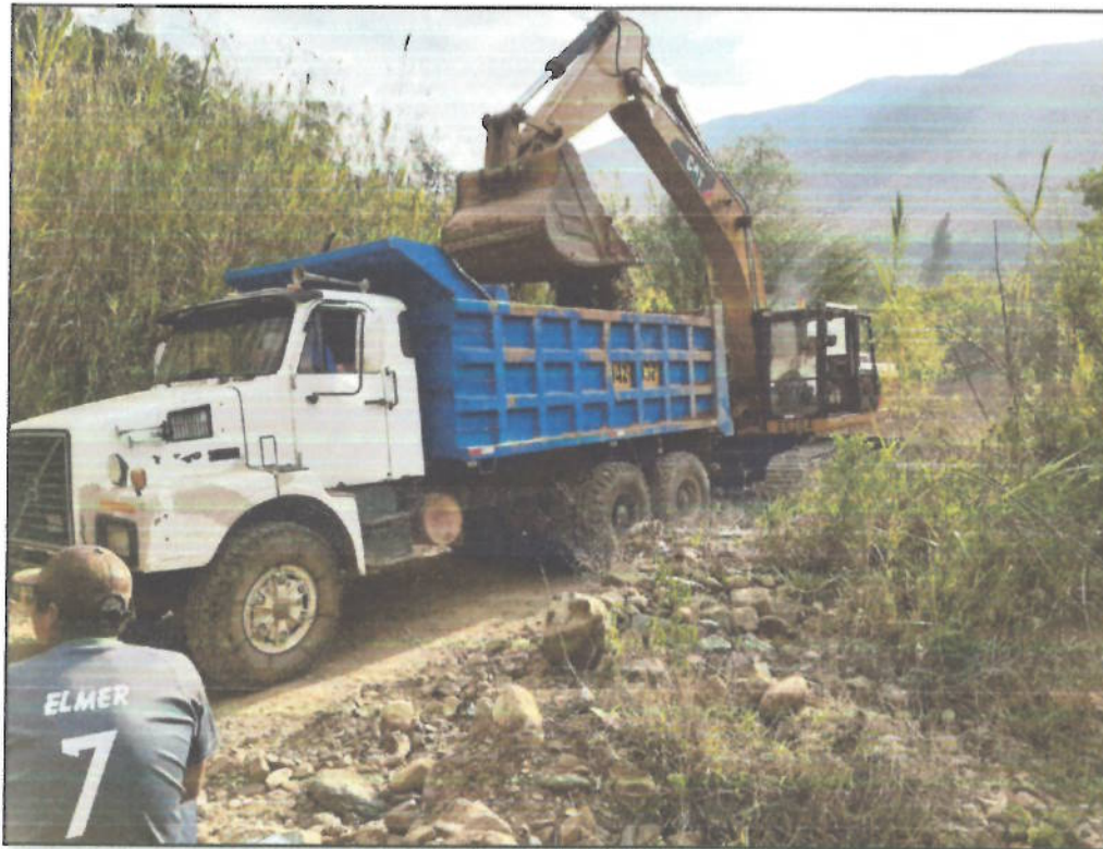
Fotografía N° 6: Trabajos de transporte de material con Volquete de 15 m3.
