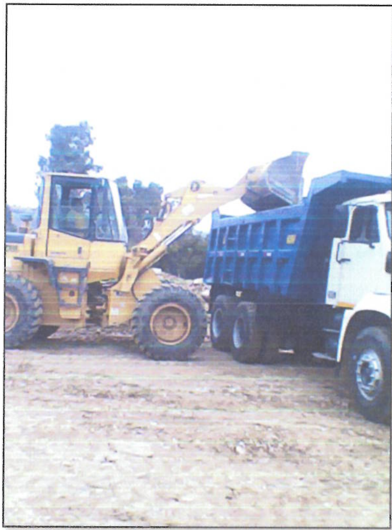
Fotografía N° 5: Trabajos de transporte de material con Volquete de 15 m3.
