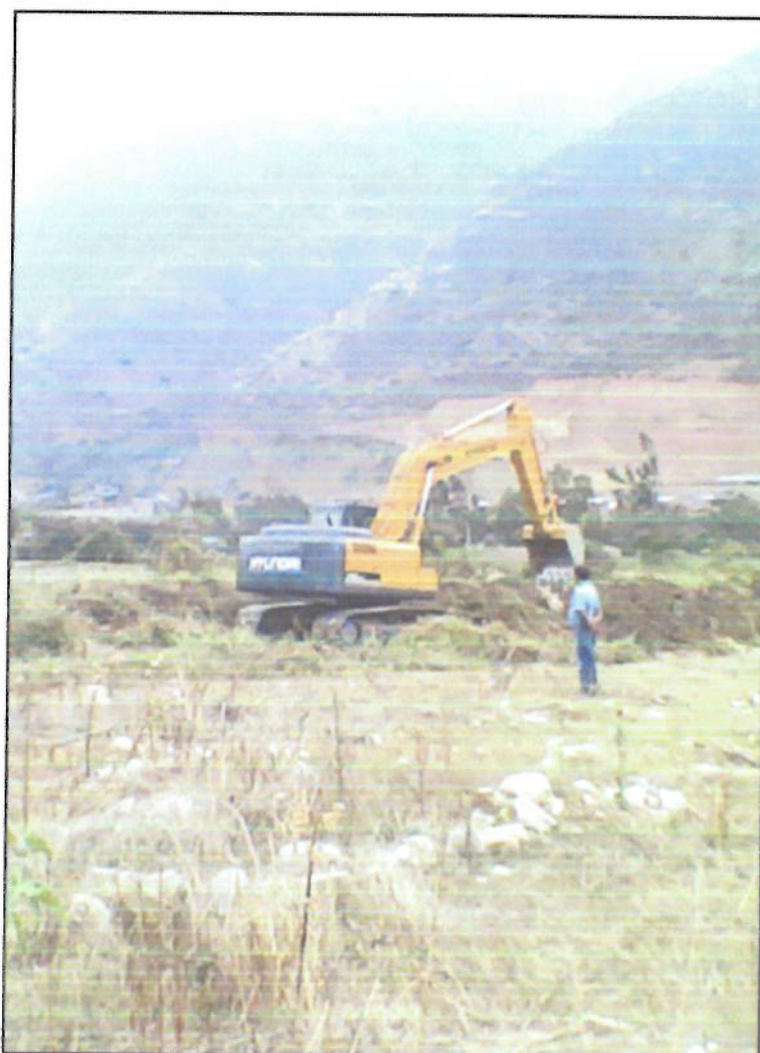
Fotografía N° 3: Trabajos de descolmatación con Excavadora sobre oruga de 115-165 HP.
