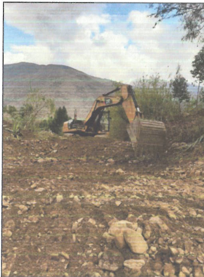
Fotografía N° 5: Trabajos de descolmatación con Excavadora sobre oruga de 115-165 HP.
