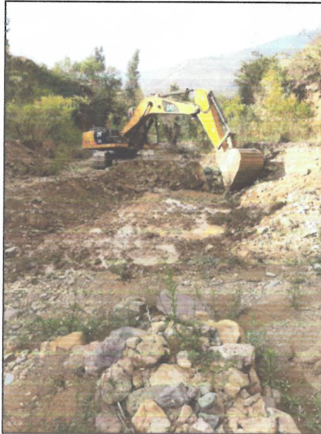
Fotografía N° 9: Trabajos de descolmatación con Excavadora sobre oruga de 115-165 HP.
