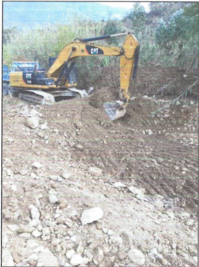
Fotografía N° 3: Trabajos de descolmatación con Excavadora sobre oruga de 115-165 HP.
