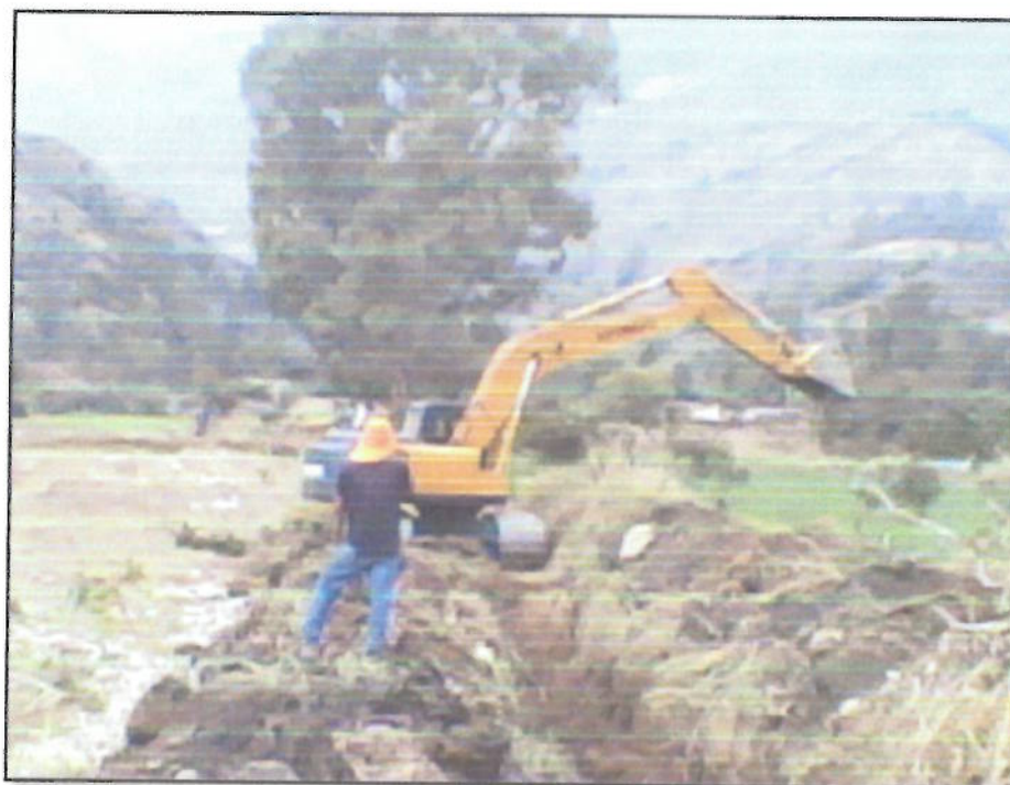
Fotografía N° 2: Inicio de los trabajos de descolmatación con Excavadora sobre oruga de 115-165 HP
