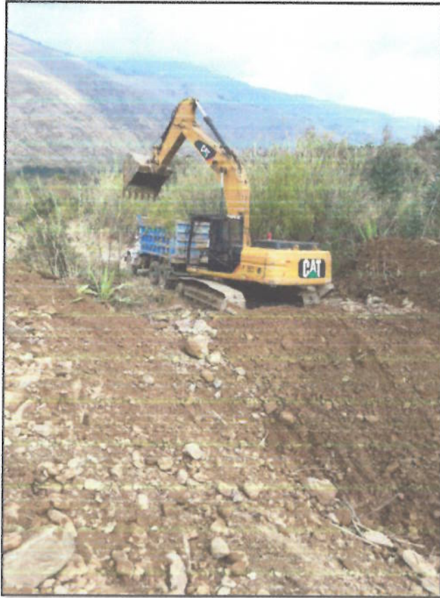
Fotografía N° 8: Trabajos de descolmatación con Excavadora sobre oruga de 115-165 HP.
