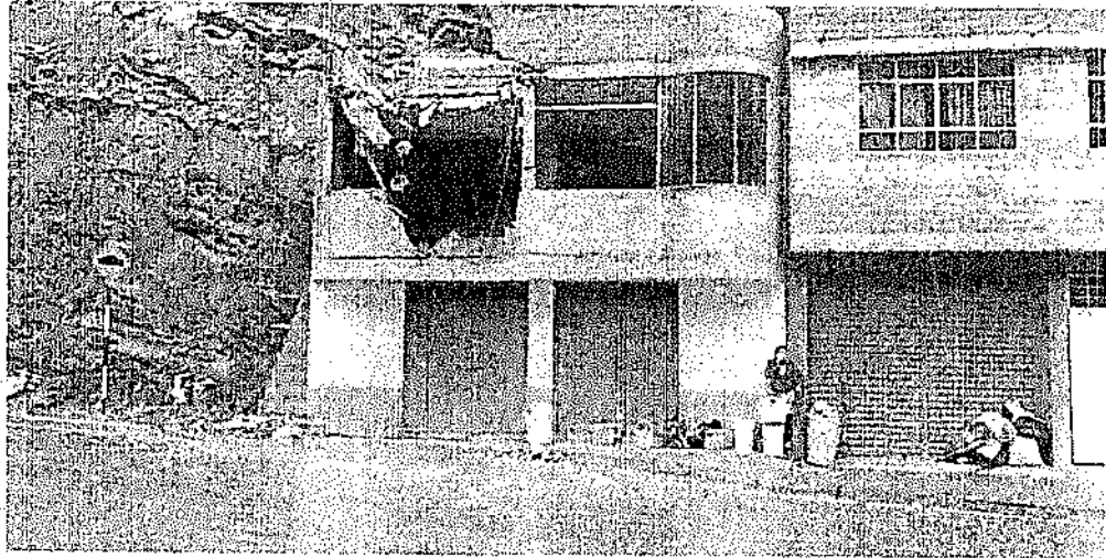
Viviendas afectadas por la caída de roca del Sr. Fredy Ramos, Presidente de la Junta de afectados
