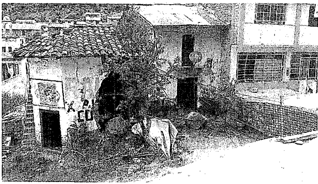
Vivienda destruida del Sr. Marmanillo, una de las 15 familias afectadas por el desprendimiento de rocas.
